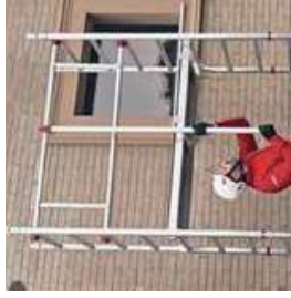
Nuovo sistema di montaggio in sicurezza dei parapetti. New safe assembly system of the guard-rails frames.
