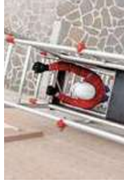
Accesso all'area di lavoro completamente protetta, grazie ai parapetti montati dal basso. Totally safe access to the working area, thanks to the assembly from below of the guard-rail frames.
