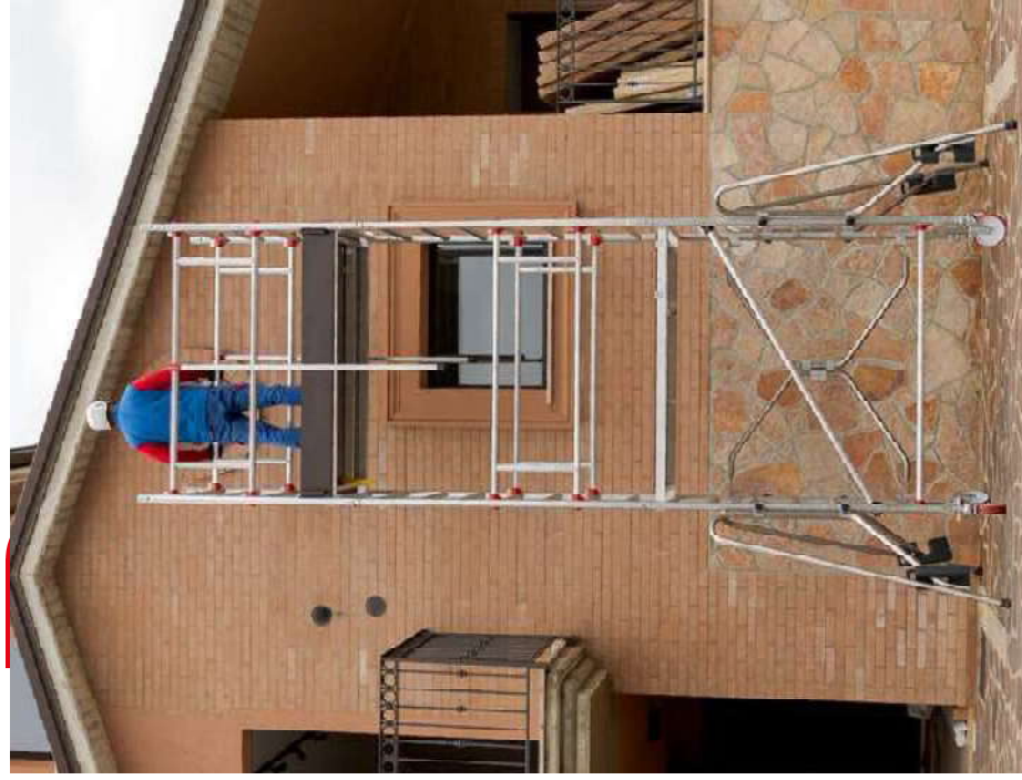
Nuovo sistema di montaggio in sicurezza dei parapetti. New safe assembly system of the guard-rails frames
